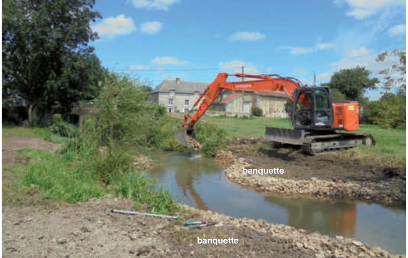
matériaux dans le lit (pierres, blocs). Aussi, cinq zones d'écoulements dynamiques à très faible profondeur seront reconstituées : il s'agit des radiers, qui alternent avec des zones plus profondes, les fosses.
